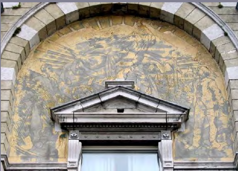
Maison du Peuple, Coopérative "Union, Progrès, Economie", Rue du Peuple 1, Pâturages, 1903, architecte F. Bodson, sgraffites Paul Cauchie.
