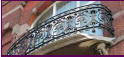
*Il faut également faire attention aux points de fixation des pièces métalliques dans la pierre qui peuvent se détériorer par la corrosion.*
