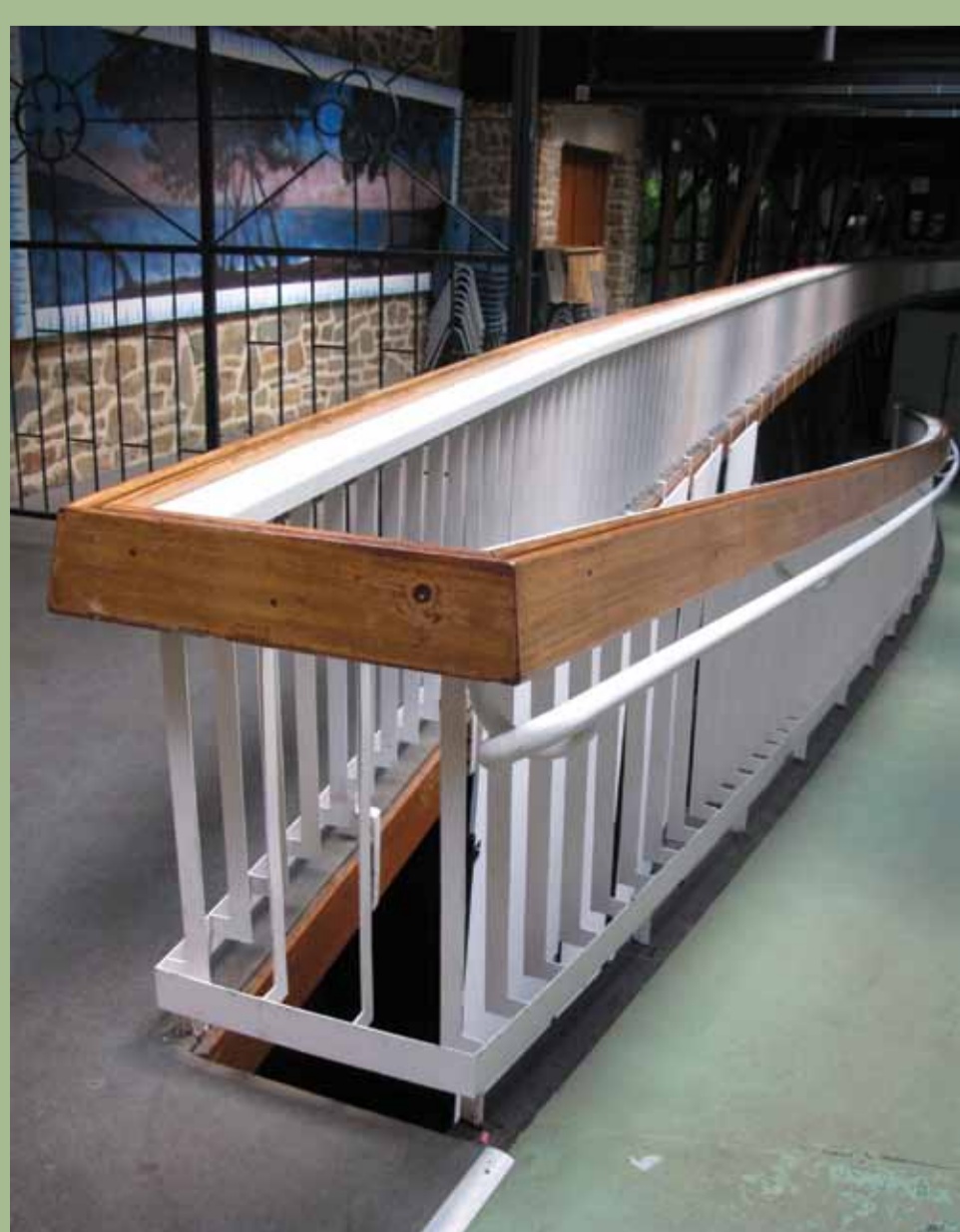
6 Comme si des arbres avaient poussé à l'intérieur du bâtiment... - © Espace Environnement Des poteaux de bois forment la structure portante. Tous les éléments de la structure (poutres, boulons) sont laissés apparents.
