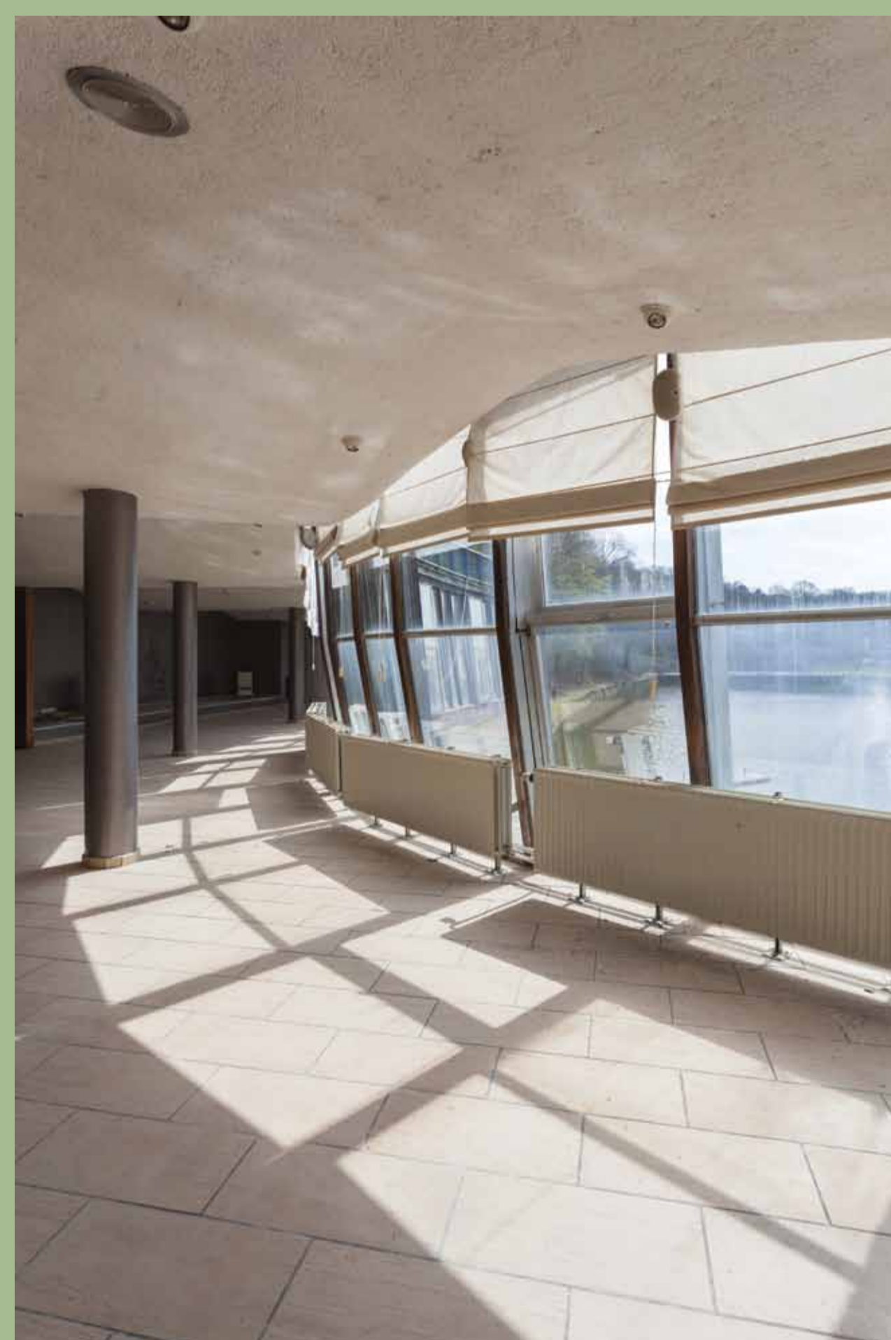
© MN Dailly Grande salle à manger ouverte vers le lac par une paroi de verre arrondie et légèrement inclinée. Les colonnes en enfilade dégagent l'espace et supportent un plafond ondulant comme un voile. La légèreté est accentuée par le détachement du mur vitré. Les châssis métalliques sont munis d'un dispositif coulissant d'ouverture.
