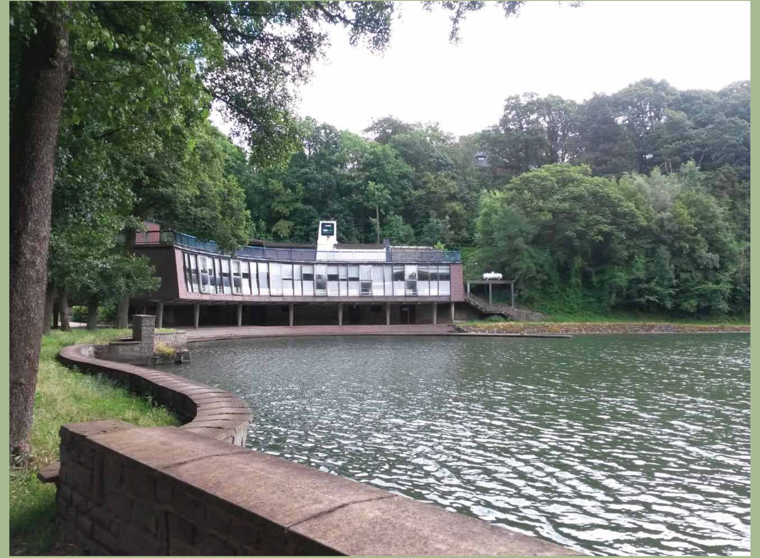
Le restaurant : façade vers le lac - © Espace Environnement
