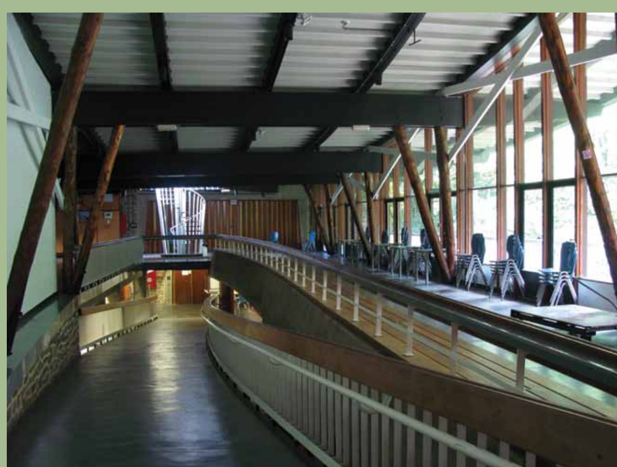
6 Comme si des arbres avaient poussé à l'intérieur du bâtiment... - © Espace Environnement Des poteaux de bois forment la structure portante. Tous les éléments de la structure (poutres, boulons) sont laissés apparents.
