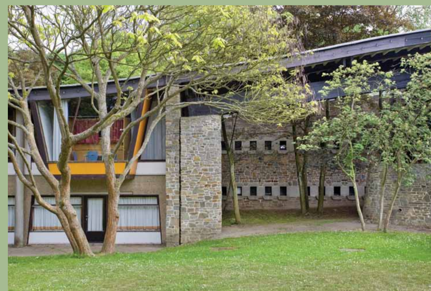
2 Façade nord : à gauche, les classes - © MN Dailly Le mélange de matériaux, bois, verre, moellons, béton... anime la façade. Les petites baies en pierre taillée forment un bandeau donnant un aspect rustique contrastant avec les grandes baies vitrées.
