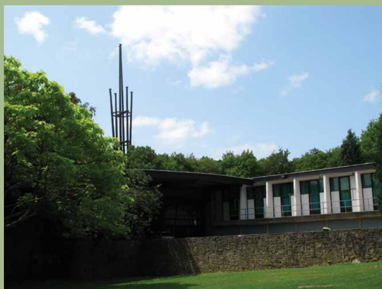
1 Façade nord : entrée - © Espace Environnement L'entrée s'ouvre par une verrière sous un auvent courbe, soutenu par un groupe de poteaux en bois inclinés, rappelant des troncs d'arbres. À droite, l'auberge de jeunesse.
