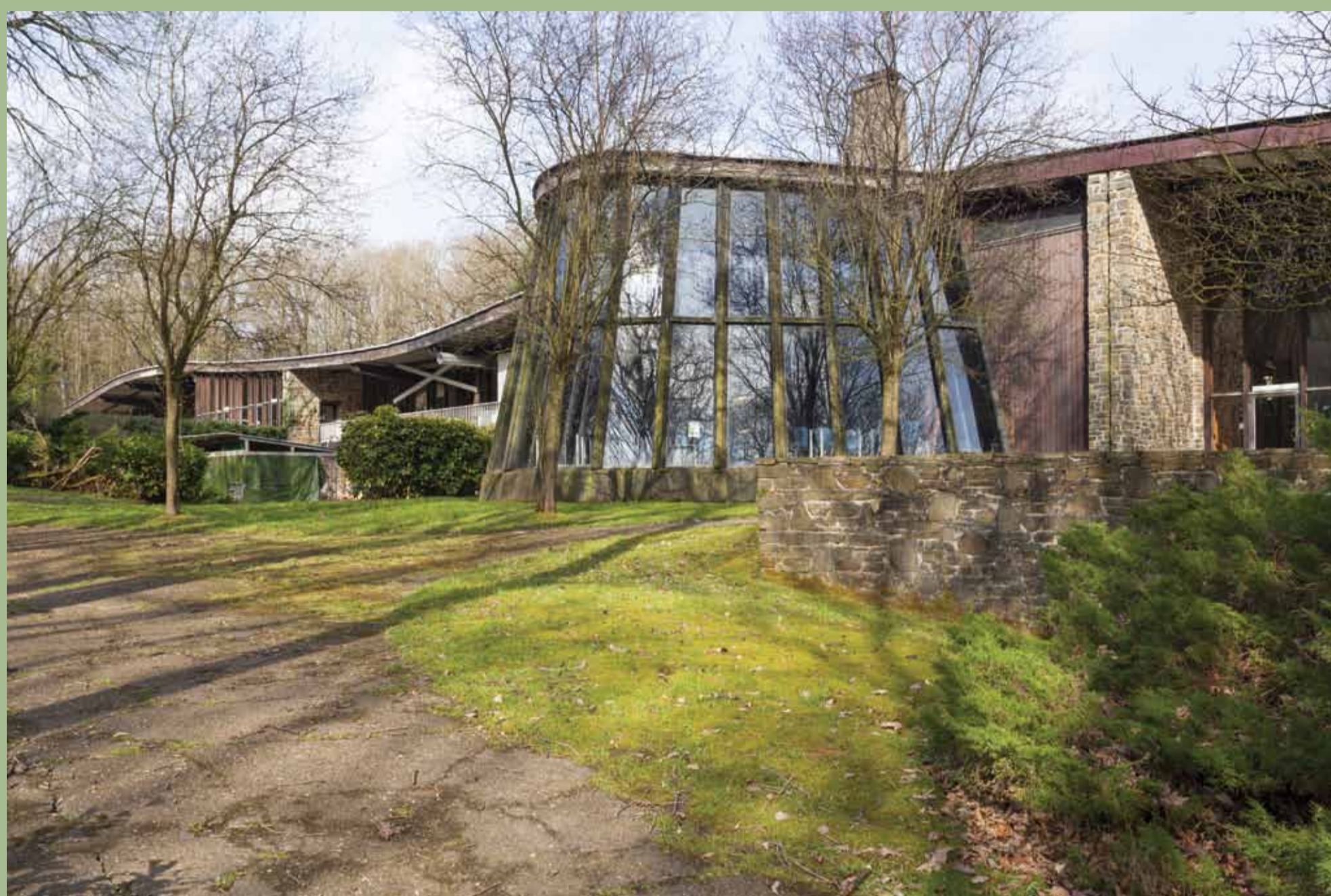
4 Façade sud - © MN Dailly La saillie de la rotonde vitrée et la sinuosité de la toiture : l'architecture est en symbiose avec le cadre boisé.
