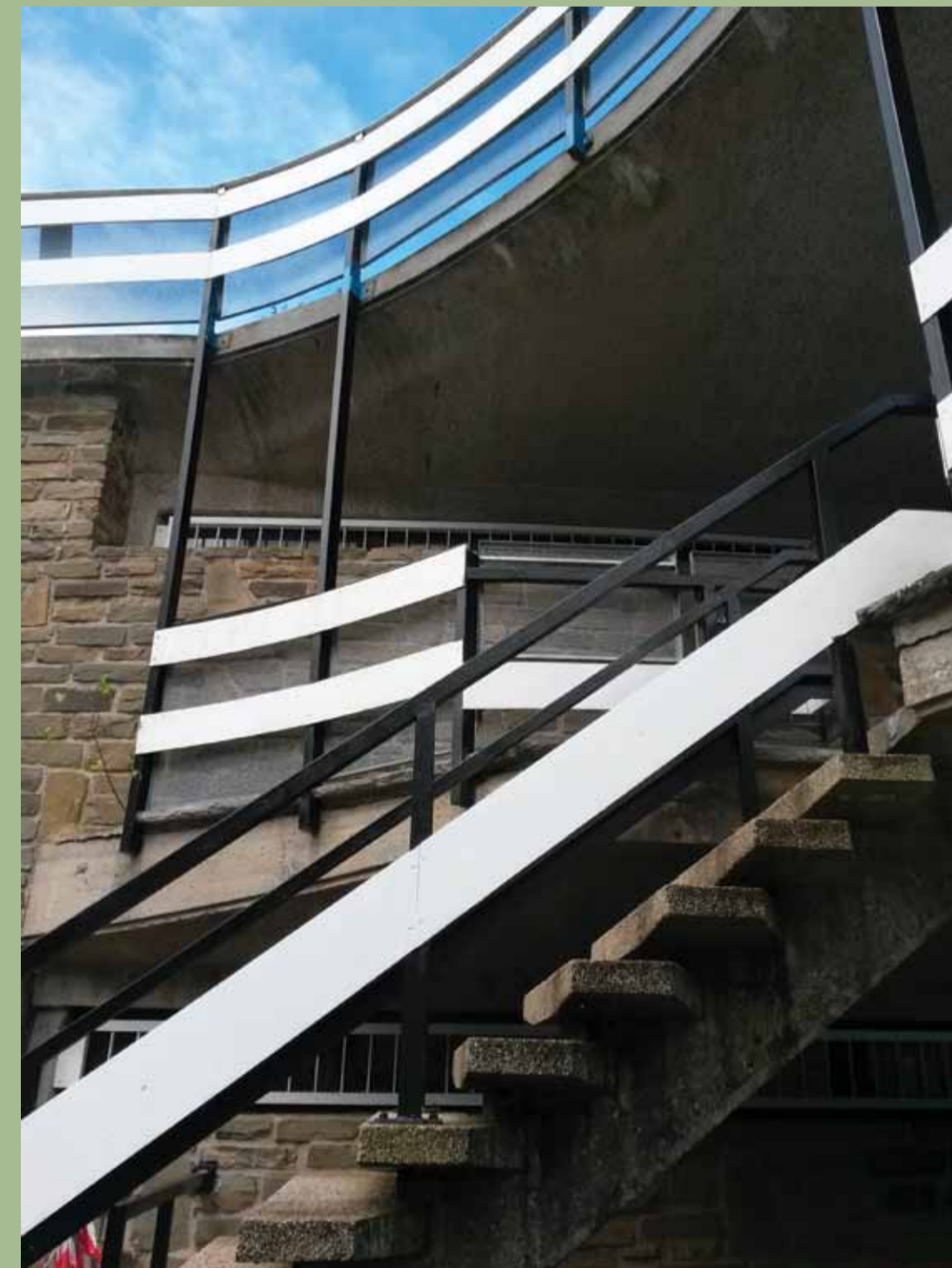
Détail du graphisme des balustrades - © Espace Environnement Escalier vers le premier étage.
